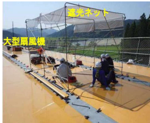
②遮光ネットや作業用大型扇風機の設置
